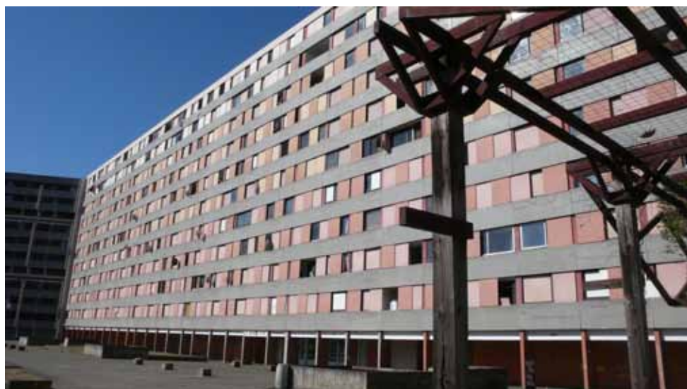
L'immeuble Concorde avant sa démolition
