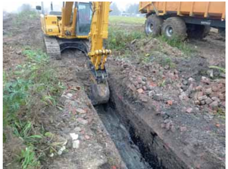
5 Phase d'excavation du produit avant démolition des structures de la galerie.
