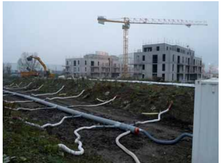
7 Le traitement sur site, au sein d'une emprise ne faisant pas l'objet de travaux d'aménagement, permet d'éviter les coûts et les contraintes d'évacuation hors site, tout en libérant l'emprise des travaux de construction. Les travaux peuvent donc commencer parallèlement aux opérations de traitement.
