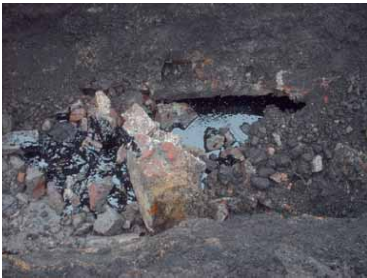
4 Découverte d'une galerie technique en brique remplie de liquide pâteux.
