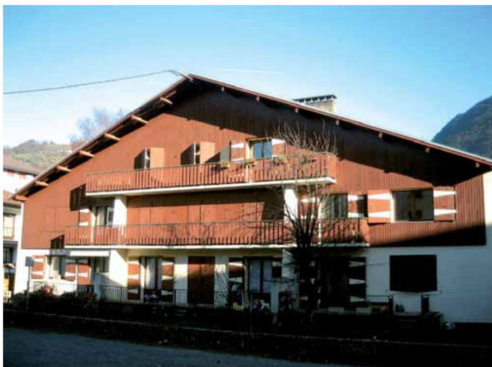
Immeuble porté par l'EPF 74 pour la commune de Cluses de 2005 à 2013.
